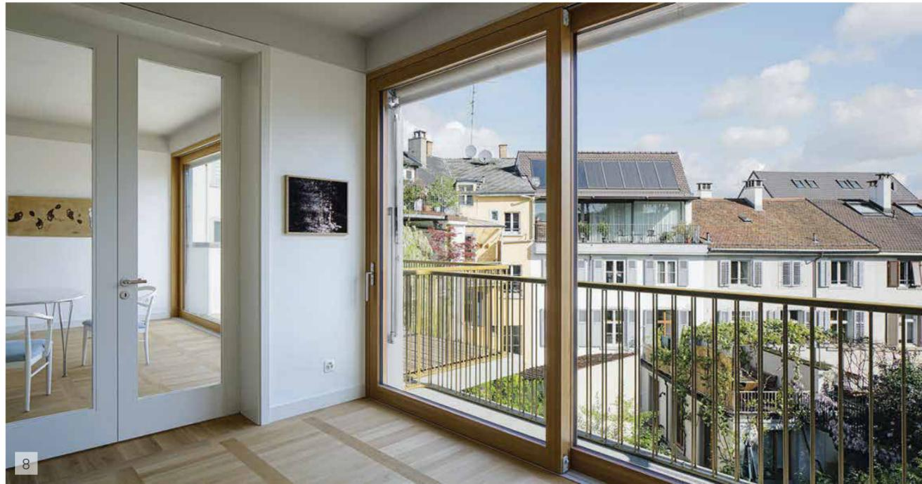
> Die Rekonstruktion der Schau­fassade war das Tüpfelchen auf dem i und gab dem Haus zur Strassenseite hin seine Würde zurück. Bis auf ein Fenster, das mit Original­beschlägen nachgefertigt wurde, konnten alle bestehenden Eichenfenster erhalten, neu isoliert und abgedichtet werden. Die gusseisernen Fensterbrüstungen wurden reproduziert und fügen sich ebenso selbstverständlich in das Fassaden­bild ein wie die neue Aussentreppe.
