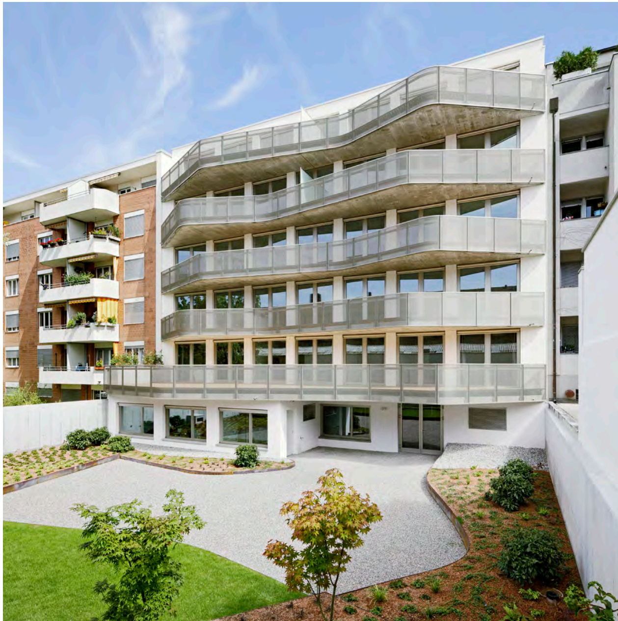
Hoffassade mit Gartengestaltung über der Einstellhalle
